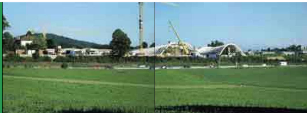
Quartier «Schöngrün» BE pendant la construction du Centre Paul Klee (15.09.2003)
