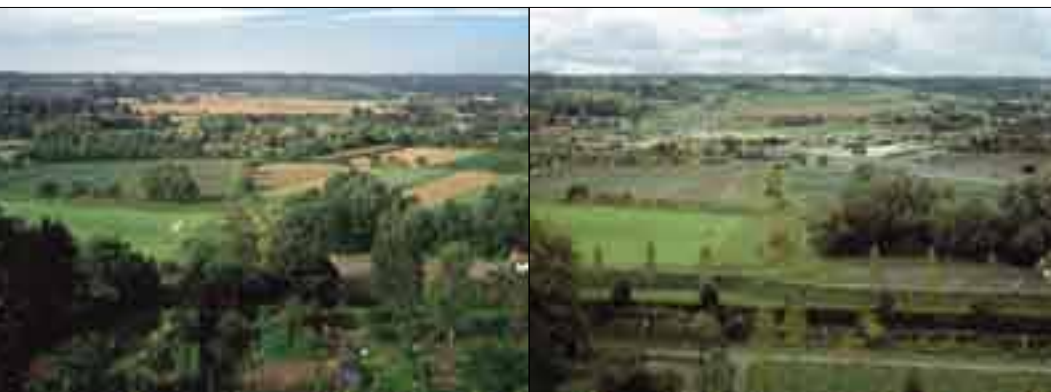
Paysage rural «Töbeli» avant et après la construction du poste de douane (A7) TG (05.08.1997 / 07.10.2002)
